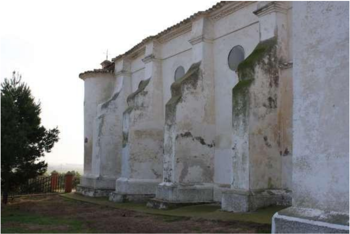
Contrafuertes del lado Norte
