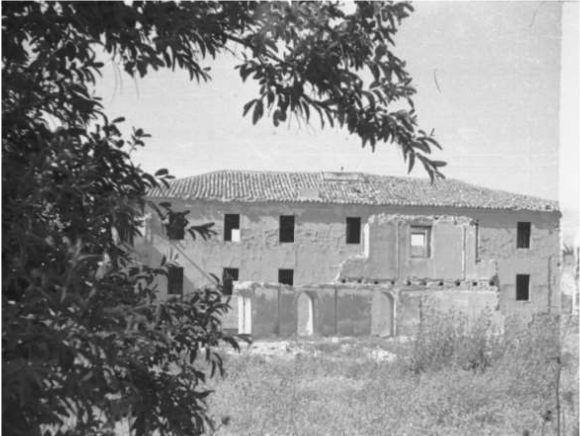
Situación de ruina de los Baños en 1969 (Francisco)
